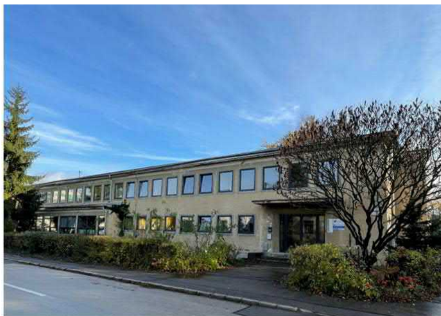
Obr. Priestory spoločnosti – pohľad zvonku
